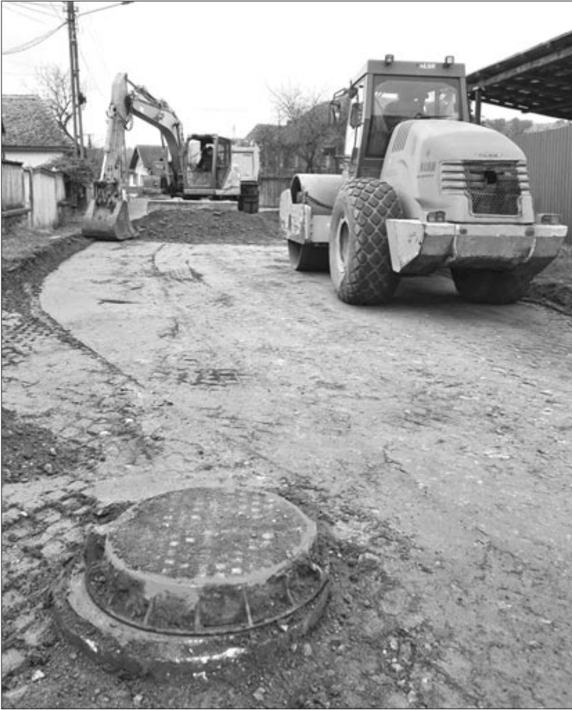
Az utcák felső rétegét eltávolítják, tömörítés után törtkőagy kerül rá alapozásként Fotó: Zakariás Botond Csaba
