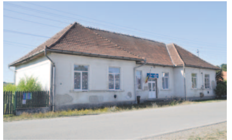
A bővítésre szánt iskolaépület
