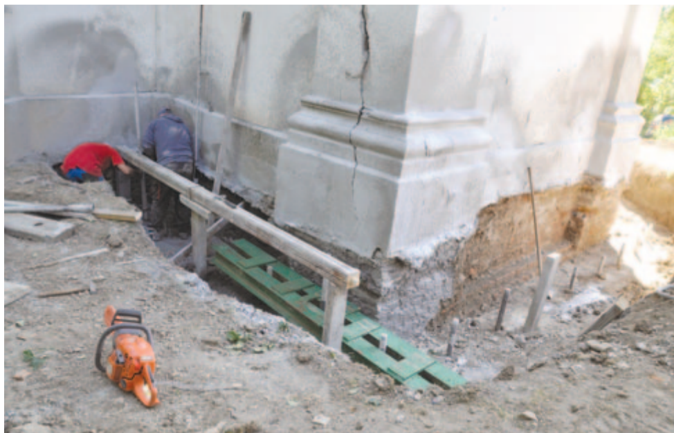
Dolgoznak a torony megerősítésén
