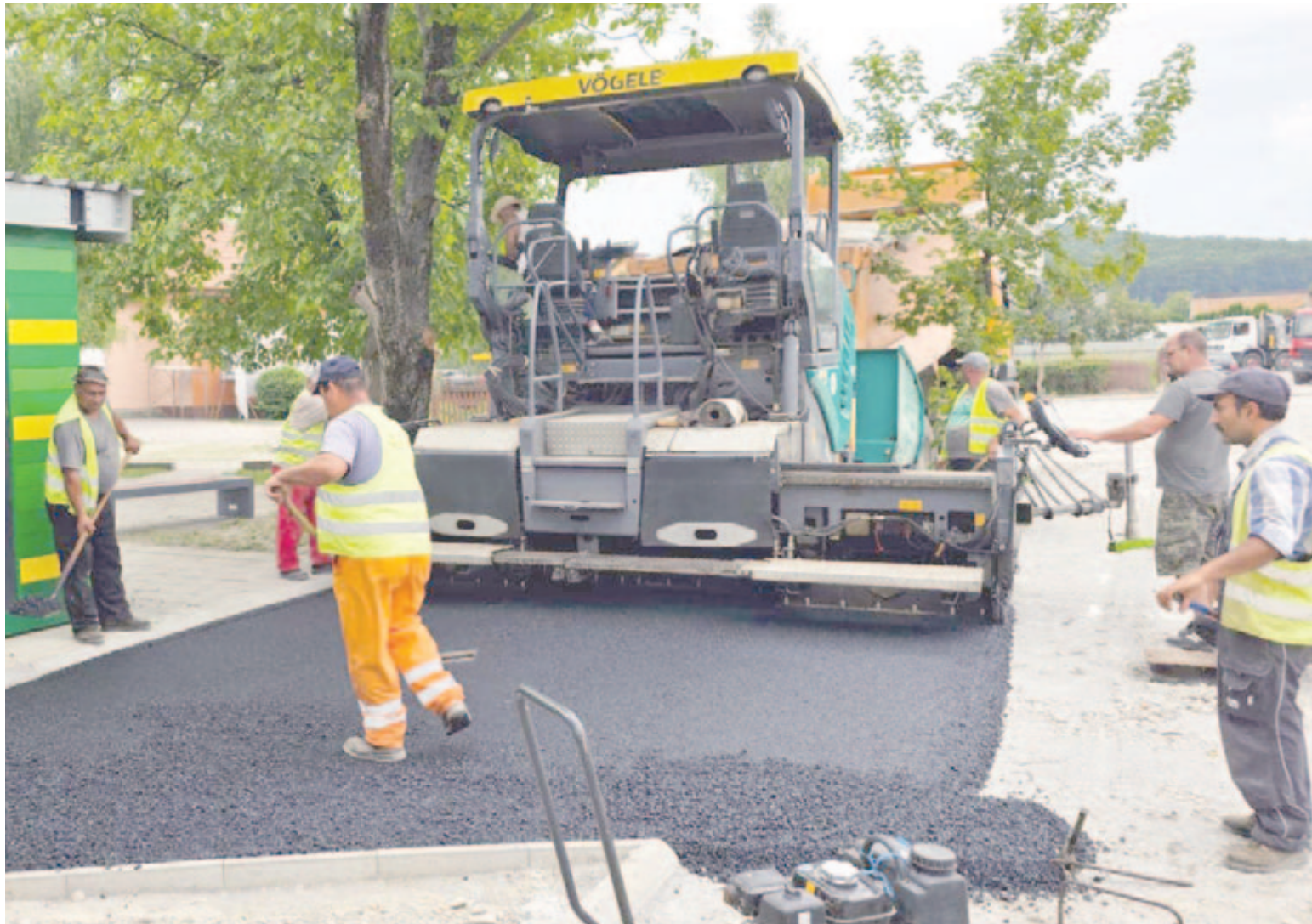
Megújul az aszfaltszönyeg, készül az okos-kerékpártároló – átalakul lassan a faluközpont képe
