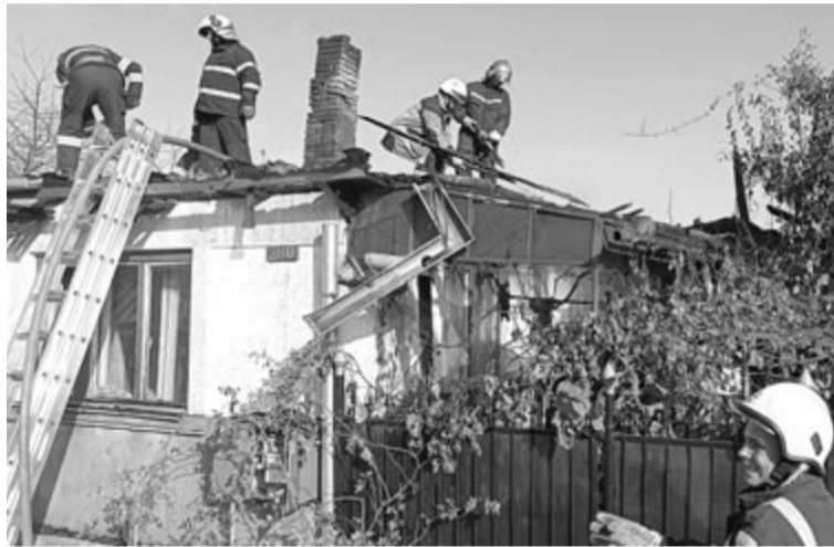
A tetőzet teljesen elpusztult, az épület erősen károsult, kiégett Fotó: A nyárádszeredai önkéntes tűzoltóság közösségi oldala
