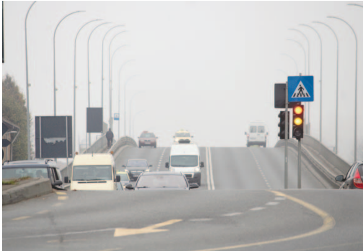
Tervben van egy új híd építése a Maroson
