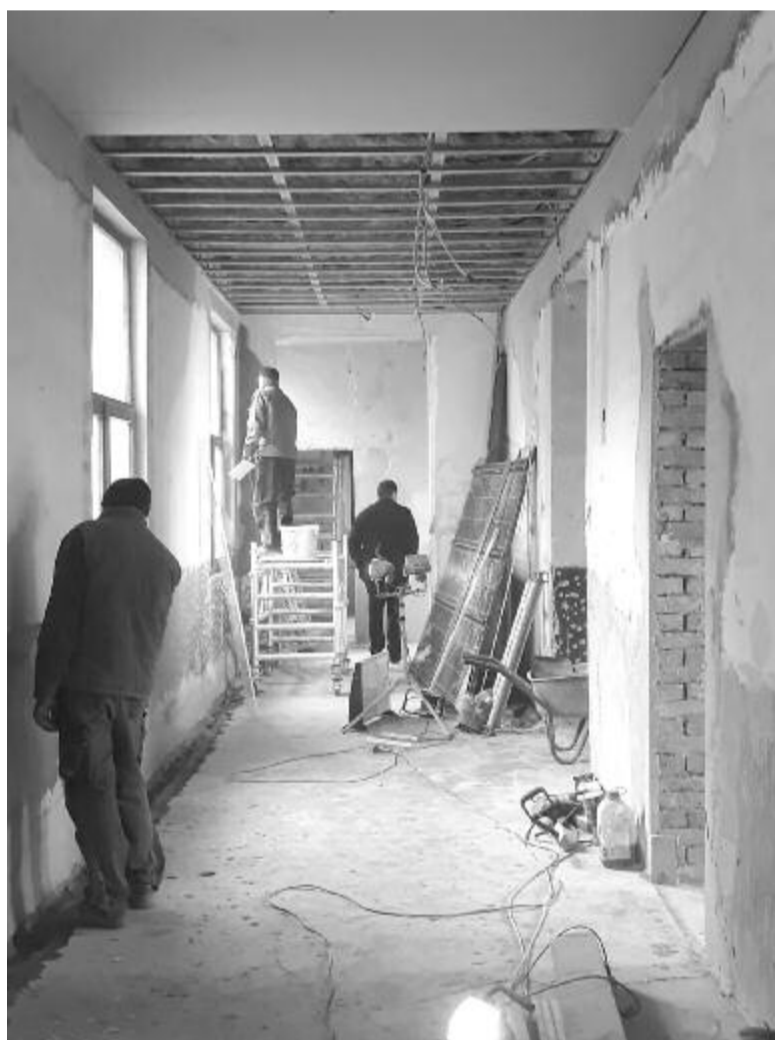
Iszlóban jól haladnak az iskolaépület felújításával
