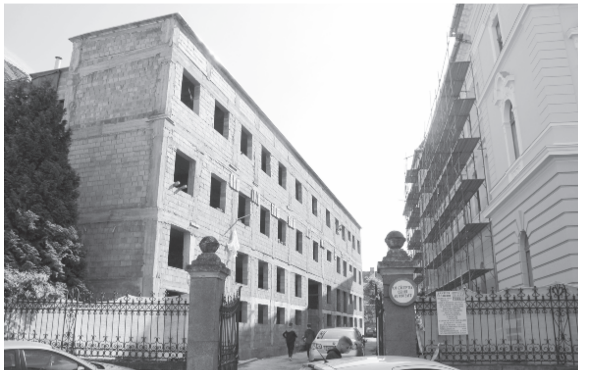
Késnek a bíróság épületének bővítési munkálataival
