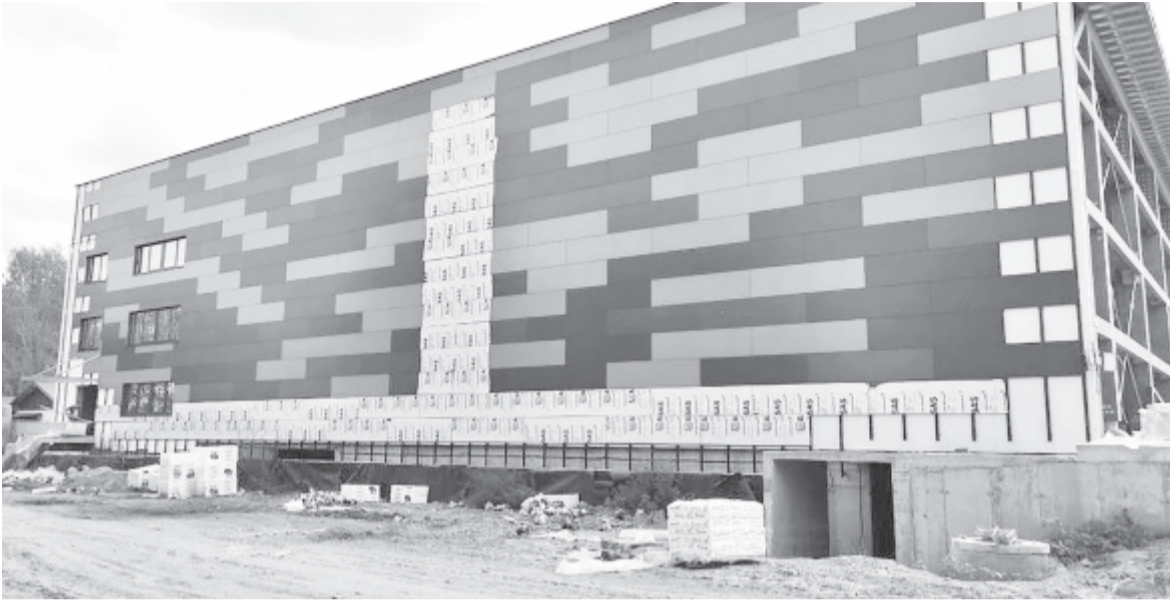
Befejezéshez közeledik az új uszoda építése, de nem lesz a város tulajdona
