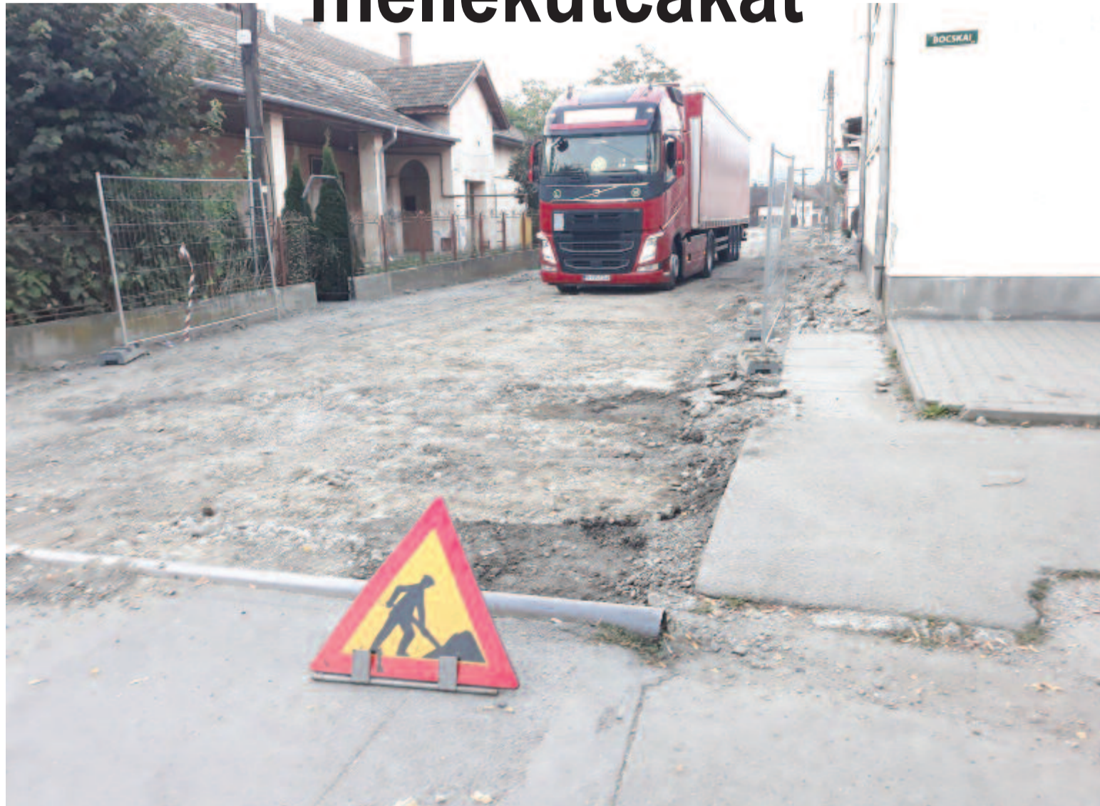
A Tuzoltó utcát lezárták a munkálatok idejére, csak az árubeszállítás engedélyezett
