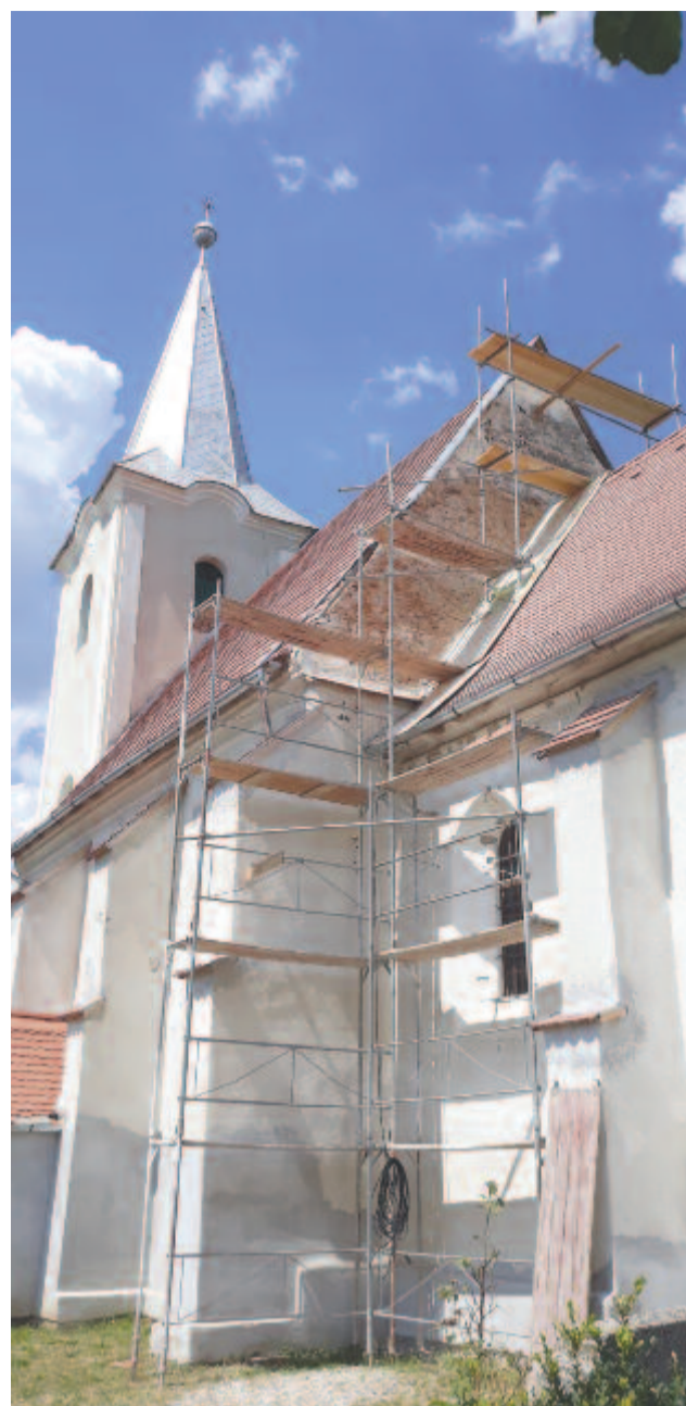
Épül az állvány, elkezdik a templomfalak javítását Fotó: Gligor Róbert László
