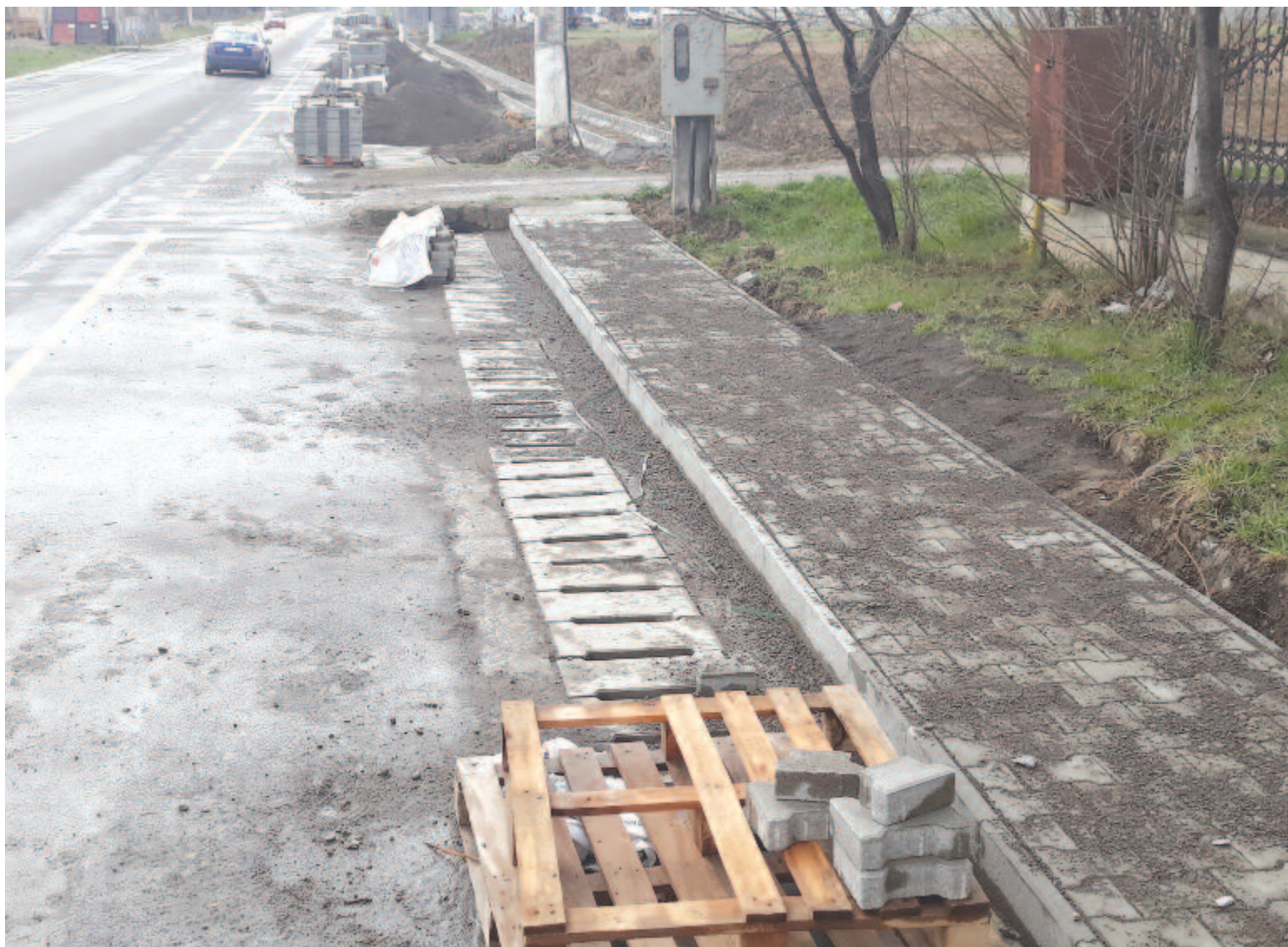
Útszelésítés, fedett sáncok kialakítása, járdaépítés – ezek csak az év első, kisebb munkálatai. A nagyobbak ezután indulnak
