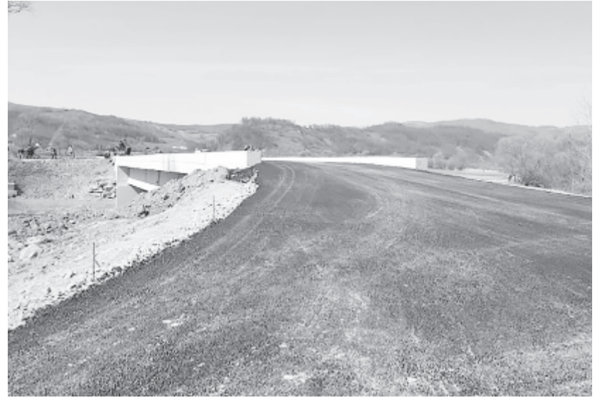
Járható az 52 méteres betonhíd
