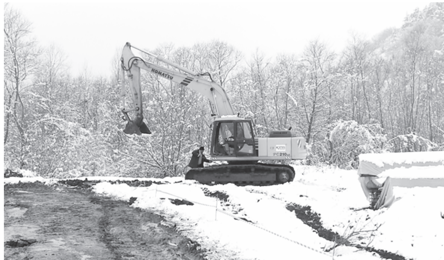
A gépek a helyszínen vannak, nemsokára elkezdik a cölöpök lesüllyesztését
